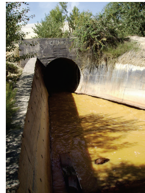
h) Kriveljska reka - izlaz iz kolektora
