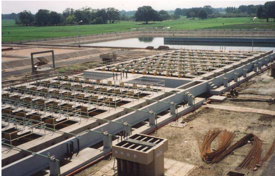
Слика 2. Изглед анаеробног постројења за пречишћавање индустријских отпадних вода у примени (Mirzapur)
