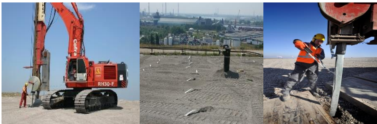
Slika 5. Savremeni sistem za sakupljanje deponijskog gasa (izvor: Multriwell, The Netherlands)
